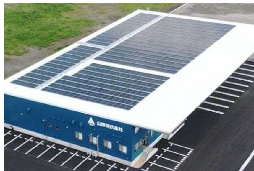
太陽光発電設備
