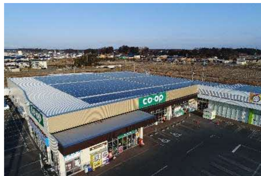
おいらせ店屋根上太陽光パネル
