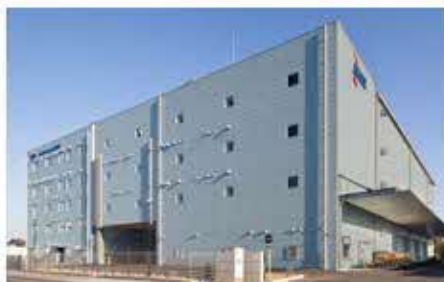
西日本鉄道(株) りんくうロジスティクスセンター (大阪府泉佐野市)
